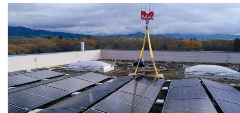
Installation der Photovoltaikanlagen in Möhlin (oben) und Freiburg (unten)
