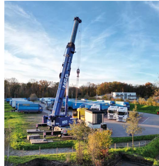
Das Trafo-Häuschen, das in der Weißerlenstraße in Hochdorf mit einem Schwerlastkran aufgestellt wurden, ist etwas Besonderes. Erstmals wurde in Süddeutschland eine solche Trafostation aus Holz mit begrüntem Dach errichtet.
